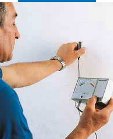
Feuchtemessung des Putzuntergrundes
