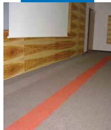
Anwendungsbeispiel für Primer G vor der Spachtelung mit Ultraplano Eco und der Verlegung textiler Beläge mit Rollcoll im Hotel Villa Castellani - Österreich
