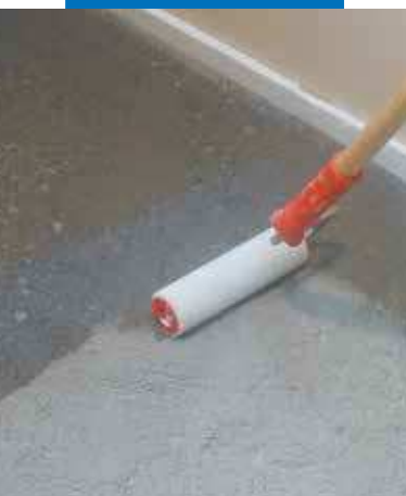
Auftragen von Primer G mit der Rolle
