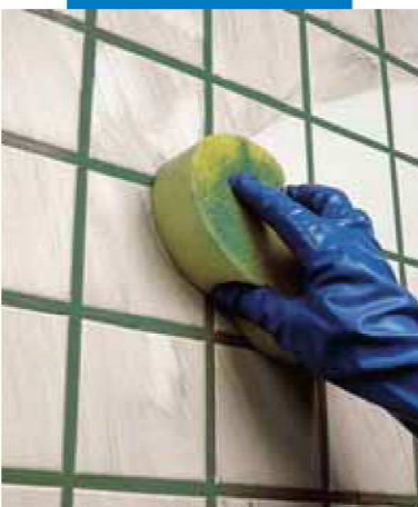
Waschen der Fuge mit einem Schwamm
