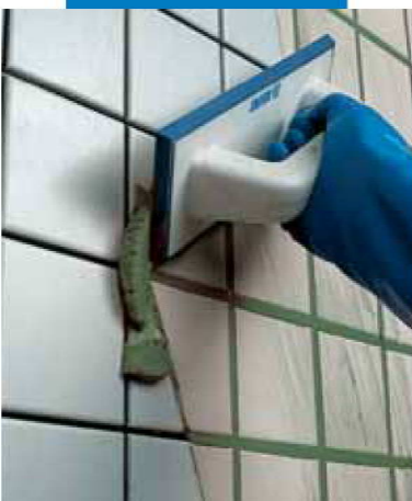
Wandverfugung mit Gummifugbrett
