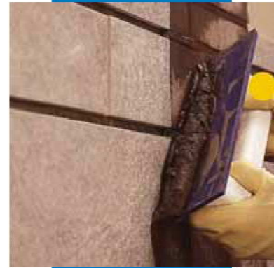
Wandverfugung mit Gummifugbrett
