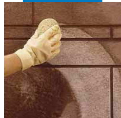
Endreinigung des Fugmörtels mit einem Schwamm
