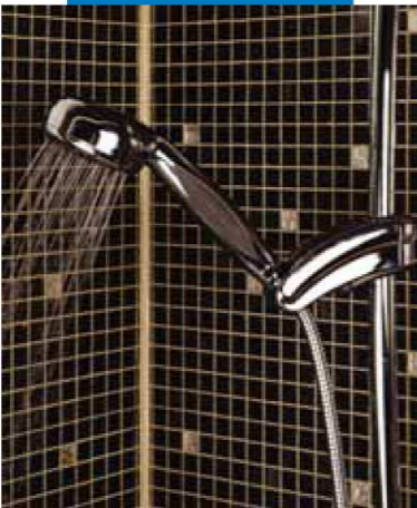
Glasmosaik verfugt mit Ultracolor Plus in einer Dusche
