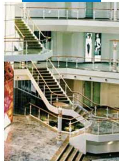
Verlegung von Fliesen und Marmor auf einer Metalltreppe
