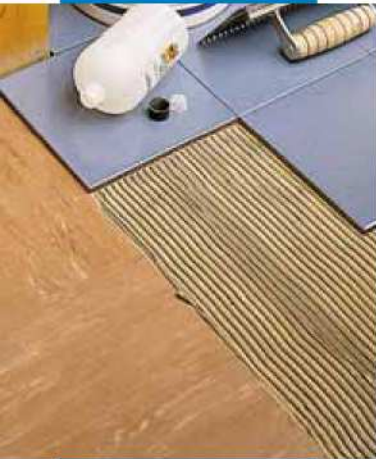
Verlegung von Fliesen auf bestehendem PVC-Belag
