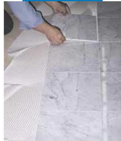
Verlegung von Carrarra-Marmor mit Keralastic-weiss auf einem Holzuntergrund
