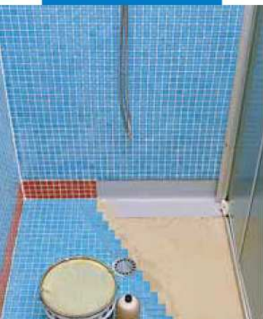
Abdichtung und Verlegung von Glasmosaik mit Keralastic
