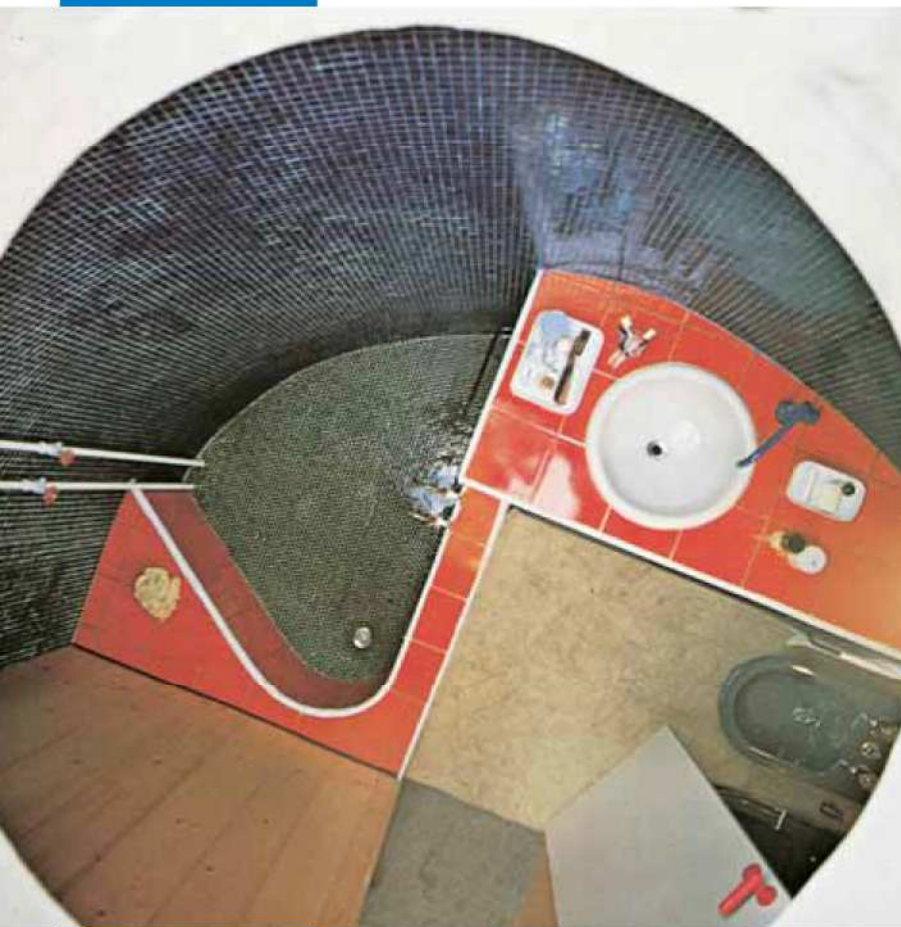
Feuchtigsperrende Verfliesung
